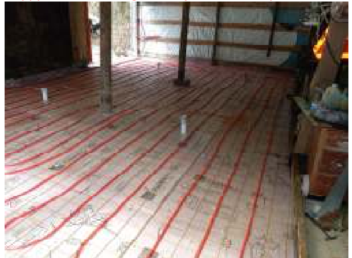
Jason's Garage Getting Ready to Pour Concrete
